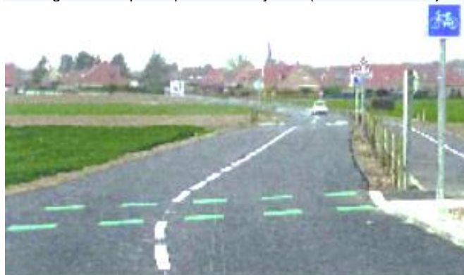
Nouvelle route Gœulzin-Férin
