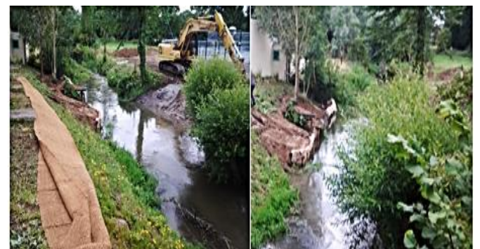
Travaux des berges au pont du city stade commencés
