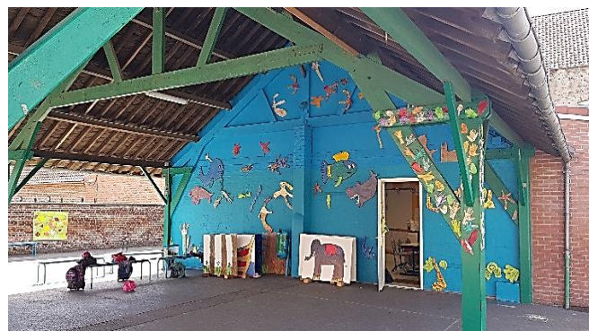
Réparation du préau d'école
