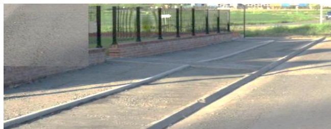
Voirie au Molinel en travaux
