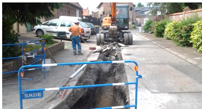
Réfection des réseaux (rue du Marais)
