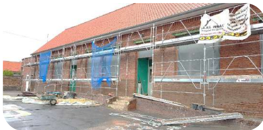
Pendant les travaux
